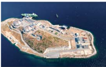
Revythousa LNG Terminal
