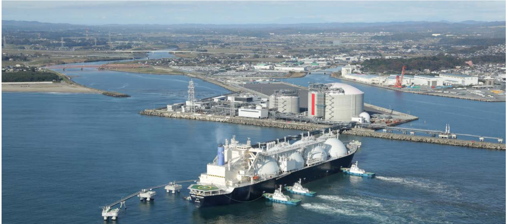
Hitachi LNG Terminal – Courtesy of Tokyo Gas
