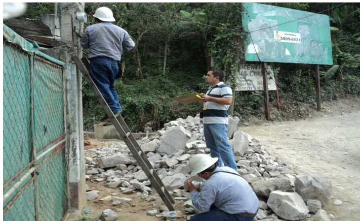
Supervisión en campo
